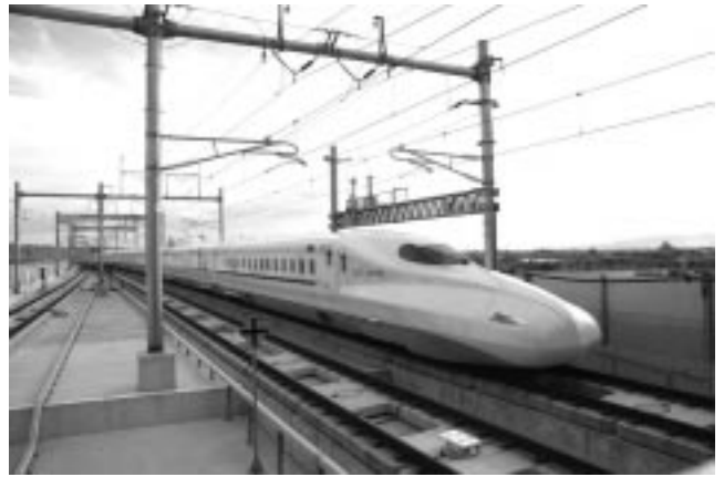
次への新しいビジョンへ。新幹線駅開業。
