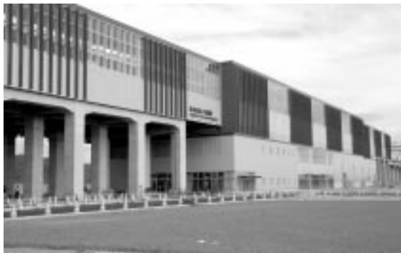
3月12日開業を待つ新幹線筑後船小屋駅
