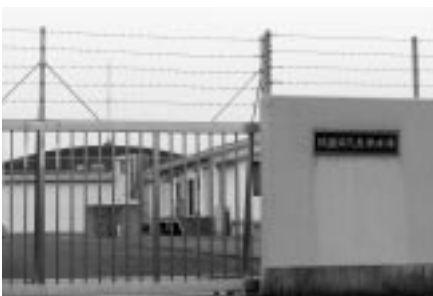
筑後市久恵浄水場
