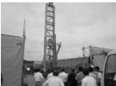
県南公園内温泉掘削現場
