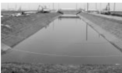
クリーク防災機能保全対策事業
