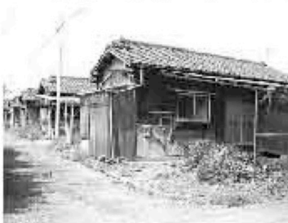
取り壊しが決まっている山ノ前団地
