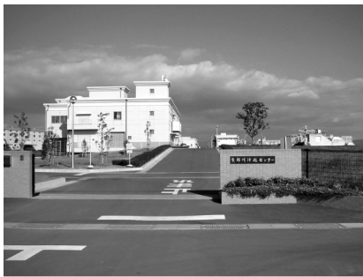
矢部川流域下水道 終末処理場(島田区)
