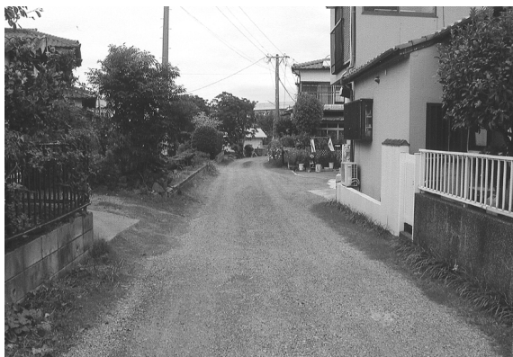
団地内の未舗装道路(熊野区) 地元施工補助制度が待たれる
