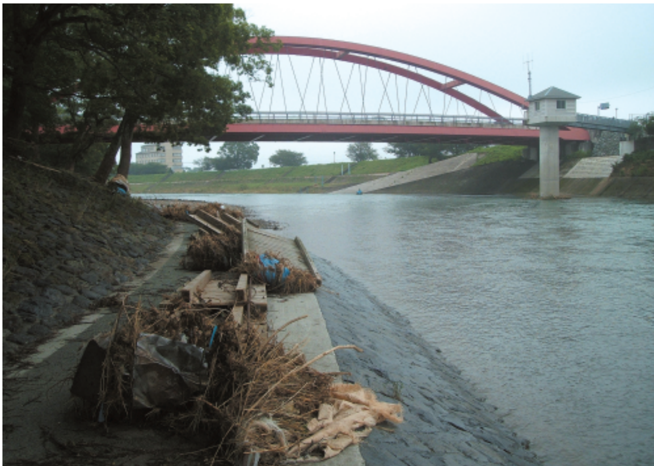
台風4号通過後のガタガタ橋(7月16日)
