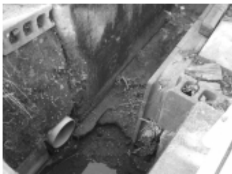
整備が遅れている水路
