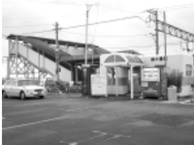
新幹線開業に伴い 移転予定のJR船小屋駅
