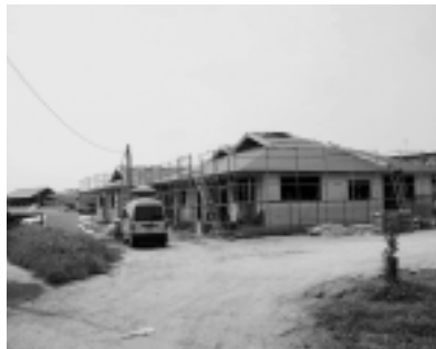
筑後北中学校区に建設中の認知症対応型通所介護事業所
