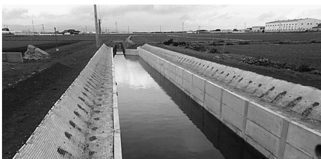
▲下富久居屋城地区水路
