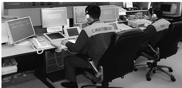
▲市消防本部通信指令室の様子
