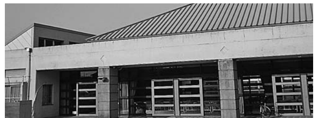
▲屋上防水工事を実施する筑後小学校ランチルーム
