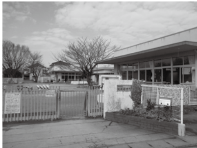
老朽化が進み建替えが検討されている筑後保育所
