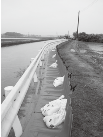
堤防に設置された簡易型止水パネル
