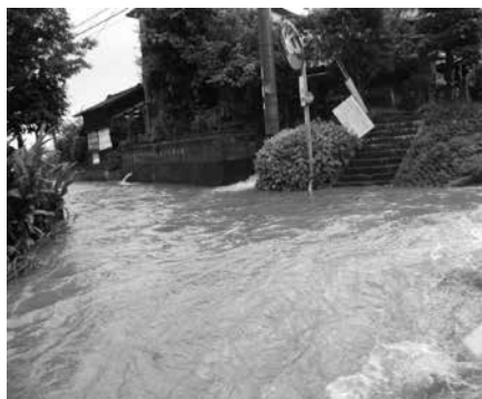
九州北部豪雨では、調整池副堤防から越流し、被害が発生した（津島東地区）
