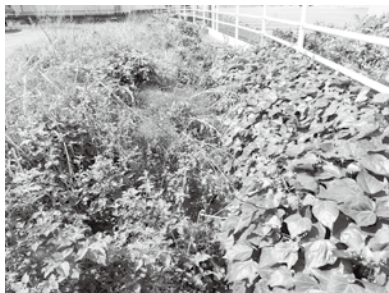
手に負えなくなってしまった水路。住民は市の支援を望んでいる
