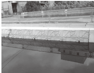
河川工事に使われている コンクリートブロック
