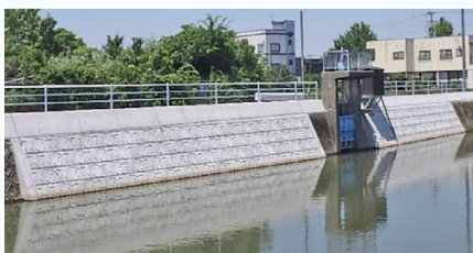
▲堤防 かさ 高上げと護岸改修などの治水対策を実施した倉目川
