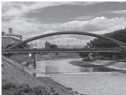
かわまちづくり計画に基づき、親水 護岸などの整備が進められている
