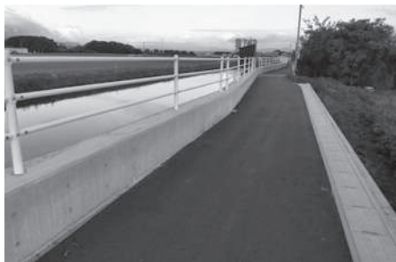
補強工事が完了した倉目川左岸堤防（下流側から撮影）
