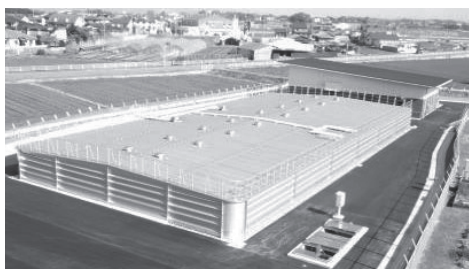
令和5年3月に完成した北牟田配水場
