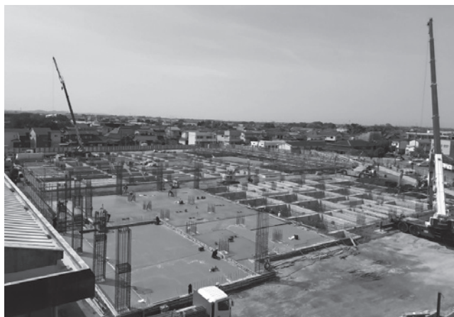
建設が進む「筑後南小学校」
