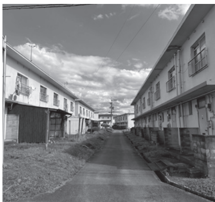
老朽化が進んでいる高銭野団地
