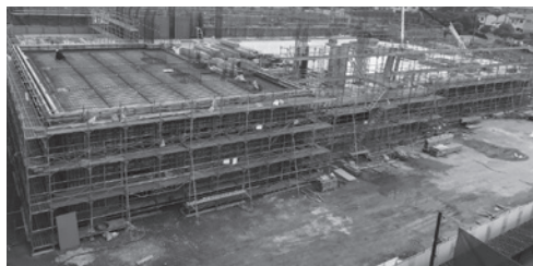
建築中の筑後南小学校体育館棟 (1階に筑後南コミュニティセンター施設などが入る)
