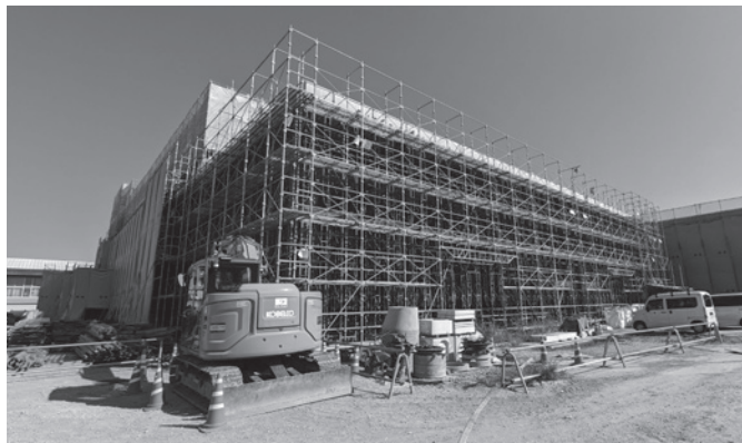
今年度末に完成予定の学童保育所（筑後南小体育館棟の1階スペース）。6年度は水田学童、7年度から筑後南学童として使用される
